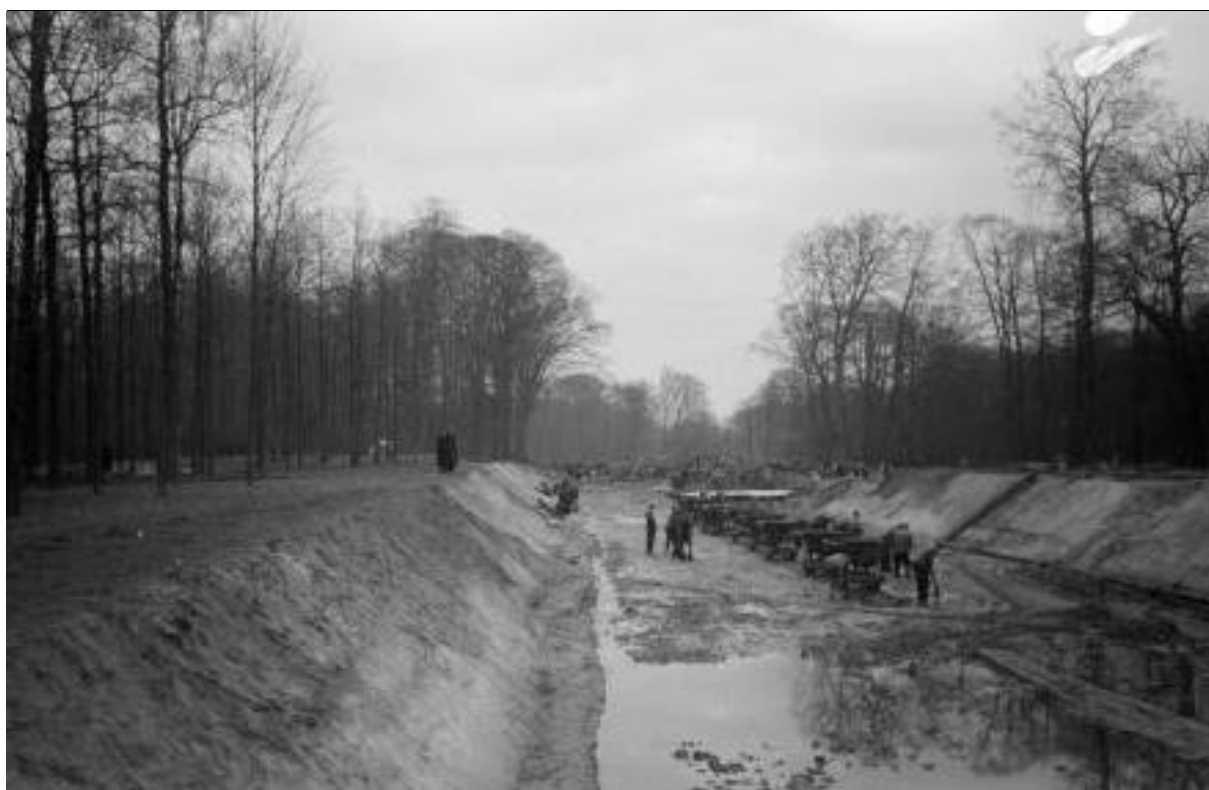
De aanleg van de tankgracht in het Haagse Bos. Bron: www.atlantikwallplatform.eu
